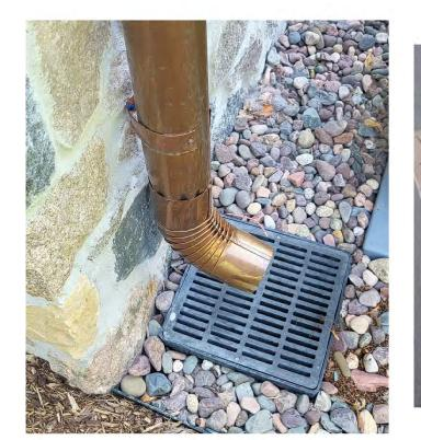
DOWNSPOUT TO DISCHARGE INTO 12" CATCH BASIN. TILE LINE TO DAYLIGHT AS GRADE ALLOWS IN GRAVEL APRON
